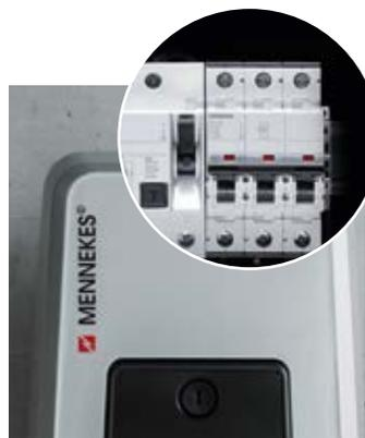
**Personen- und Leitungsschutz.** Für die Installation einer Heimpladestation ist ein FI-Schalter (Personenschutz) und ein LS-Schalter (Absicherung) vorgeschrieben. Diese Komponenten sind in den meisten AMTRON® Varianten bereits integriert. Das ist für Sie am günstigsten. Sie erkennen damit Störungen direkt am Gerät und können diese komfortabel mit dem Multifunktions-taster selbst beheben.
